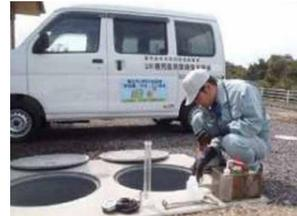
10人槽以下の定期検査は効率化した検査を実施しています
