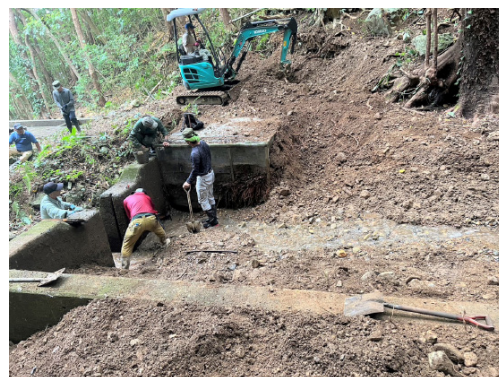
【写真】芦検集落・板子久地区 水源地の土砂撤去作業
