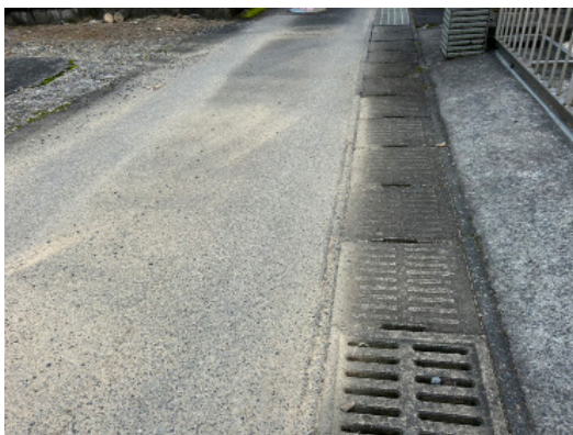
【写真】 田検集落内の村道の側溝のふた
