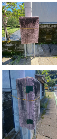
破損している消防ホース格納庫
