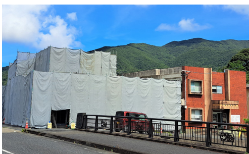
建設中の診療所
