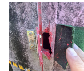
破損している消防ホース格納庫
