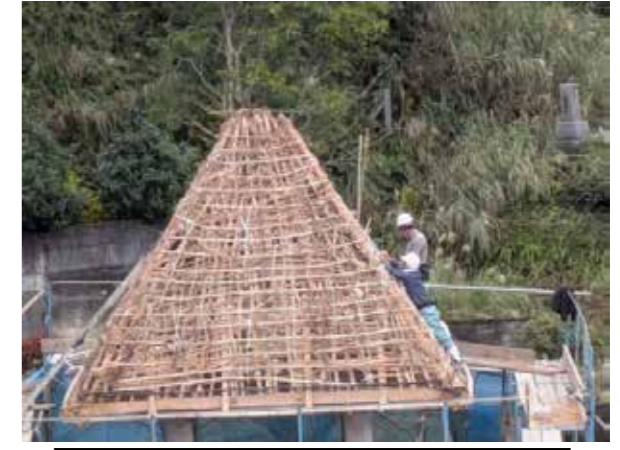
▲前の材料を全て剥がした状態
