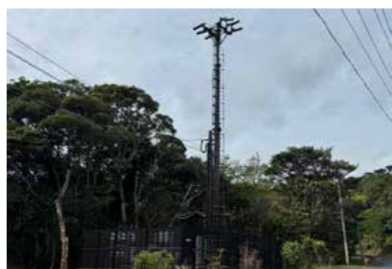
【完成した電波塔（赤土山）】
