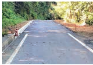
▲屋鈍曾津高崎線の工事現場の様子
