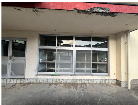
▲廃止となった阿室校給食室
