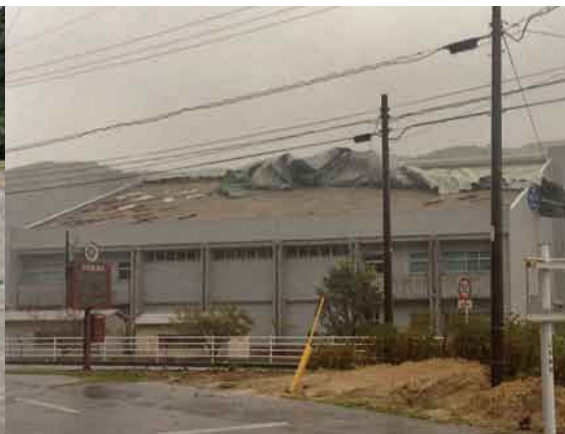
台風 15 号により屋根の片側が大きく剥がれる宇検村総合体育館
