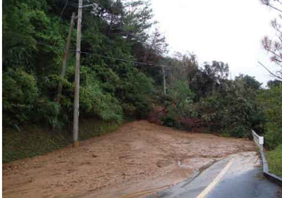
台風15号の影響で発生した須古～部連間の崖崩れ
