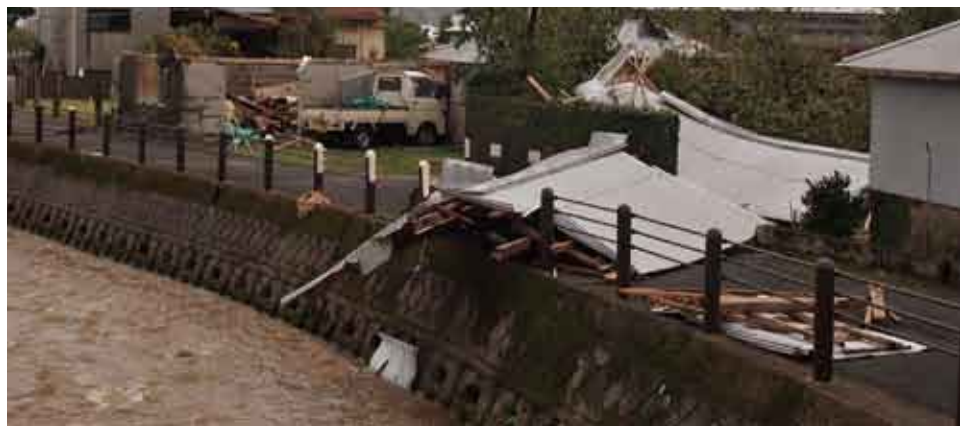
台風17号により倒壊し飛ばされた倉庫（阿室）
