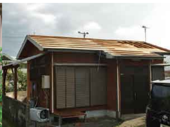
台風 17 号で屋根のトタンが飛ばされ大きな穴が開いた住宅（阿室）
