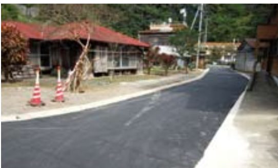
▲ 現在、湯湾集落内に整備中の防災道路
