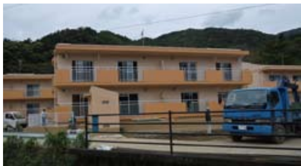
▲ 平成23年度で建設が終了する湯湾地区川田団地
