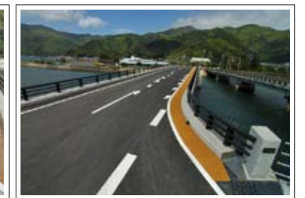
▲宇検村・瀬戸内町では最長の橋が完成。右側に見えるのが旧須古橋
